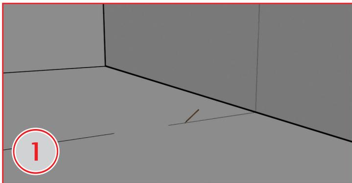
Нанести розмітку на підлогу, стіни та стелю. Розмітка має бути нанесена по одній із сторін майбутньої конструкції (з урахуванням ГКЛ).
