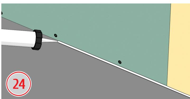
По периметру конструкції заповнити шов поліуретановим герметиком **A4Sound Flex**
